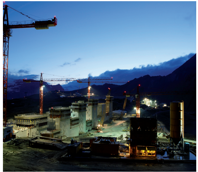
Pumpspeicherkraftwerk Linth-Limmern, Arbeiten an der Staumauer
